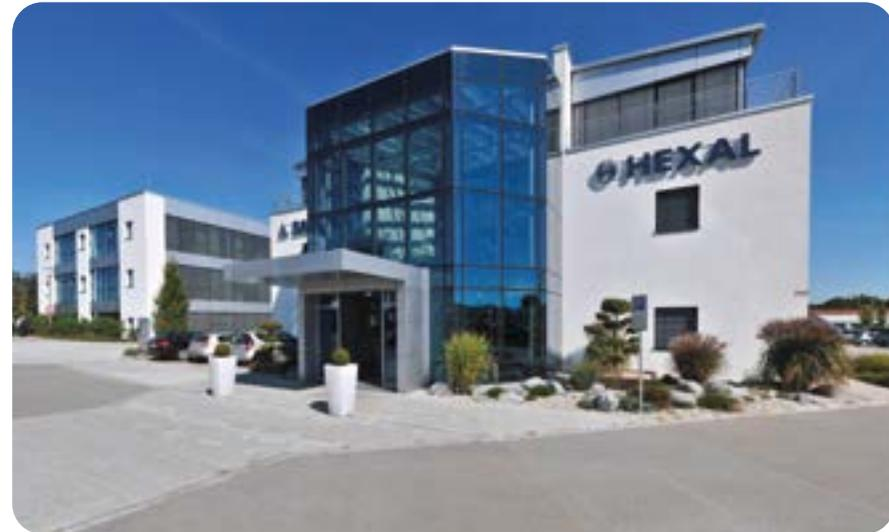
Bürogebäude in Massivbauweise und repräsentativer Eingangsbereich mit Glasfassade in Pfosten-Riegel-Bauweise.
